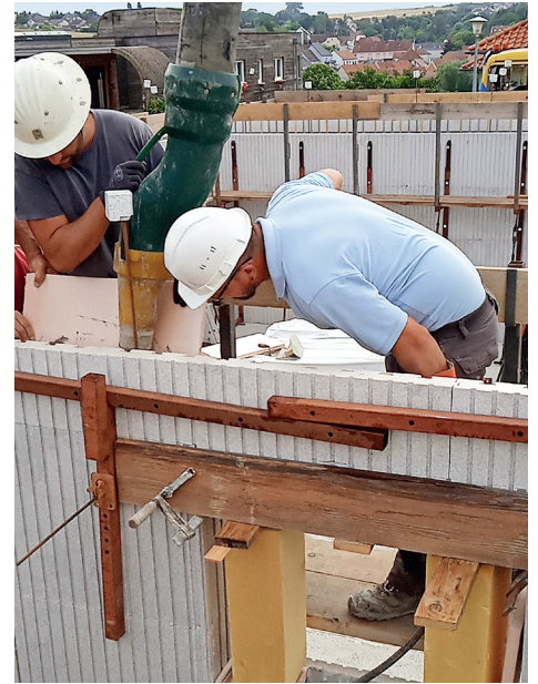
COULAGE JUSQU'À 3 MÈTRES Béton type S3 0-16 Assistance et conseils sur chantier
