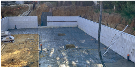
RÉALISATION DE SOUS-SOL ENTERRÉ Y compris étanchéité
