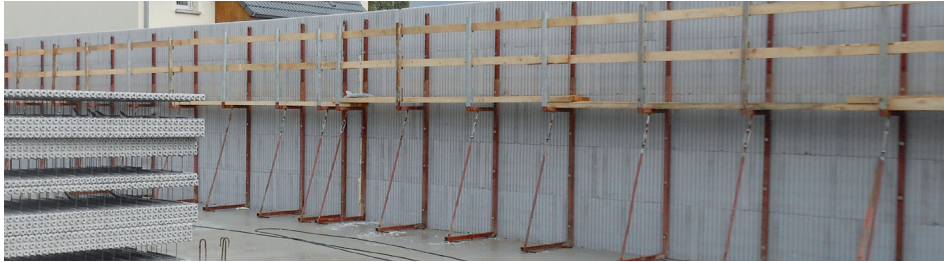
PLANÉITÉ ET APLOMB Avec notre système d'étais (tirant-poussant), les murs sont parfaitement alignés et sécurisés
