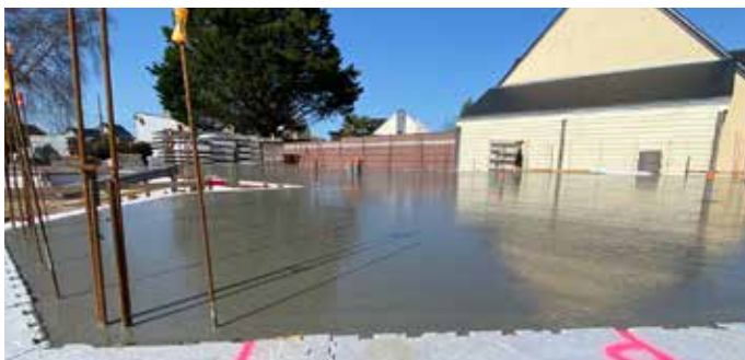
3 EN 1 > COULAGE SIMULTANÉ Dalle, poutrelles et murs si besoin
