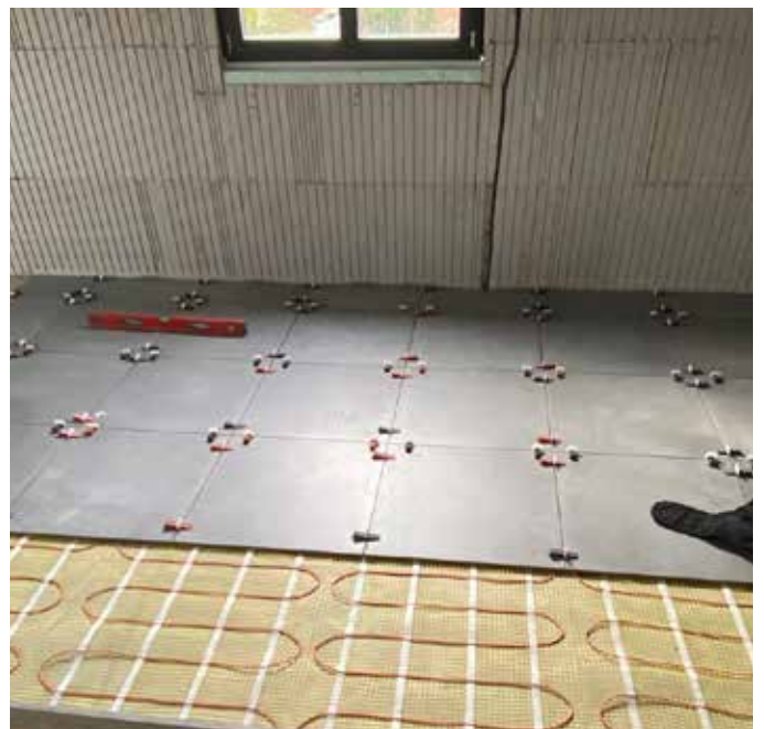
CHAUFFAGE ÉLECTRIQUE PAR LE SOL Directement dans la colle à carrelage
