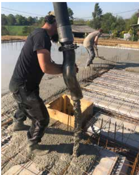
3 EN 1 > COULAGE SIMULTANÉ Dalle, poutrelles et murs si besoin
