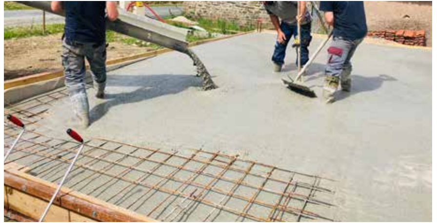
SIMPLICITÉ ET RAPIDITÉ Coulage une fois les ferrillages posés
